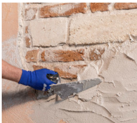
Vyrovnání a oprava omítky
