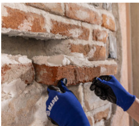
Rekonstrukce cihlového zdiva
