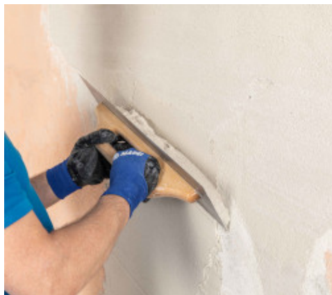
Vyrovnávání starého podkladu
