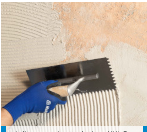
Aplikace první vrstvy Antique NHL Eco Restauro
