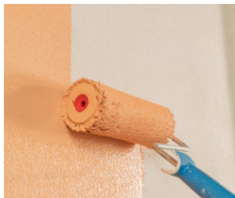
Nátěr podkladů opravených výrobkem Mape-Antique NHL Eco Restauro
