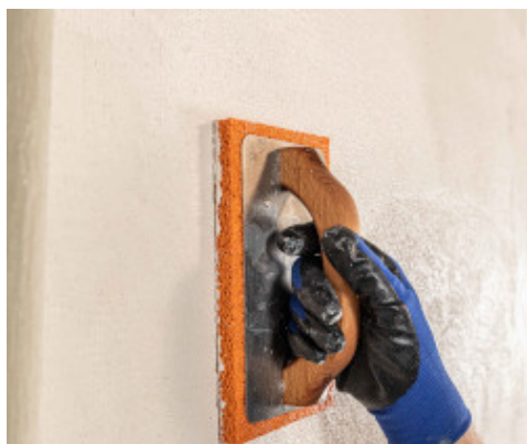
Dokončení povrchu houbovým hladítkem
