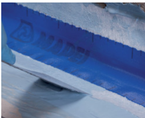
Zapracovanie pásky Mapeband v styku steny a podlahy s použitím Mapelastic AquaDefense
