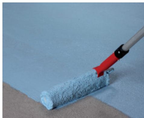
Aplikácia prvej vrstvy Mapelastic AquaDefense na poter
