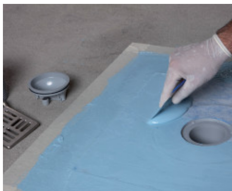
Impregnácia tkaniny Drain Vertical s použitím Mapelastic AquaDefense
