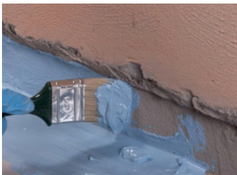
Aplikácia Mapelastic AquaDefense s použitím štetca v styku steny a podlahy, pred zapracovaním pásky Mapeband
