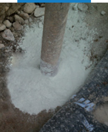
Aplikácia Mapeproof Seal okolo prestupujúceho potrubia
