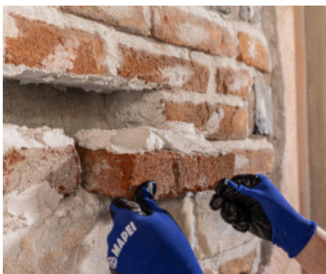
Oprava pôvodného tehlového muriva
