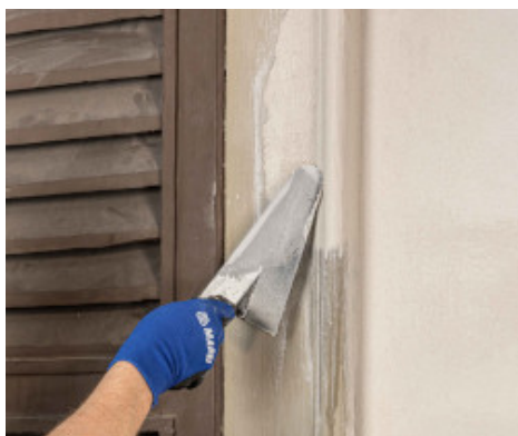
Oprava konštrukčných prvkov
