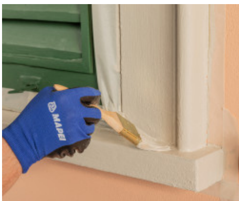
Farebné ošetrenie konštrukčného prvku
