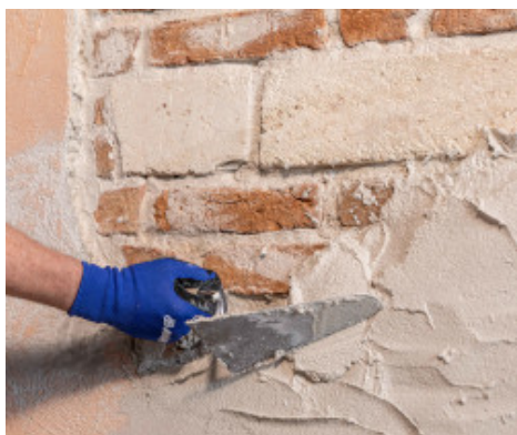
Vyrovnanie a aplikácia opravnej malty
