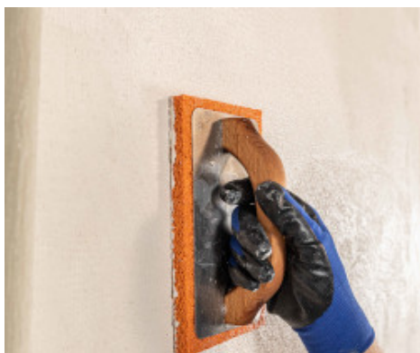
Dokončenie povrchu špongiovým hladidlom
