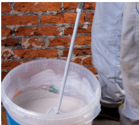
Príprava Mape-Antique Rinzafo
