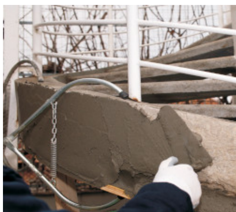
Ručná aplikácia Mapegrout 430
