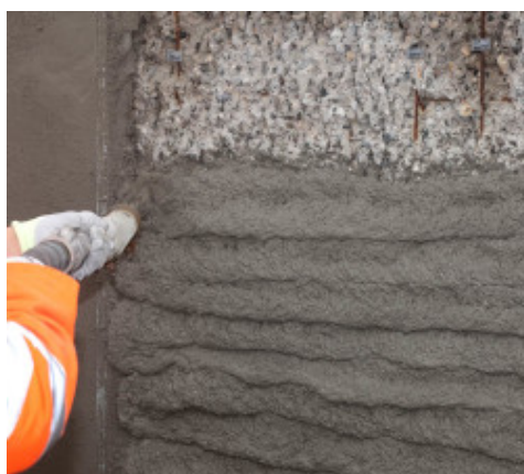
Strojná aplikácia Mapegrout 430
