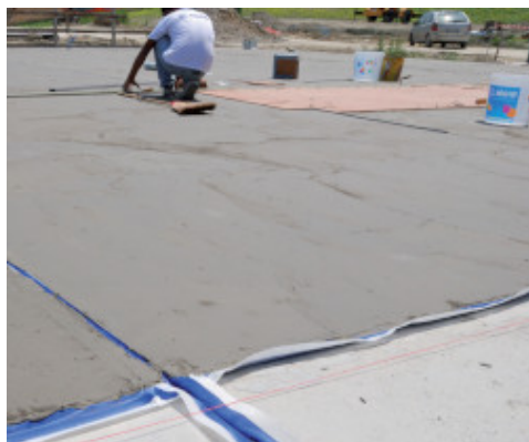
Izolovanie cementového poteru s použitím Mapelastic a Mapeband
