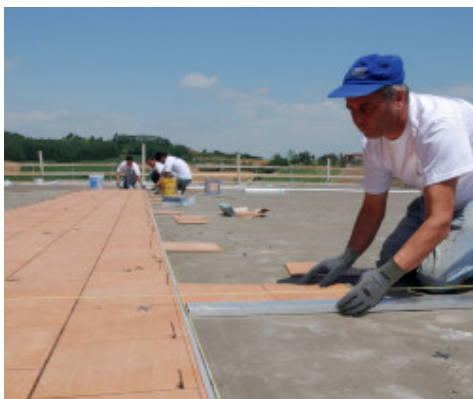
Inštalácia keramickej dlažby s lepidlom Kerabond + Isolastic
