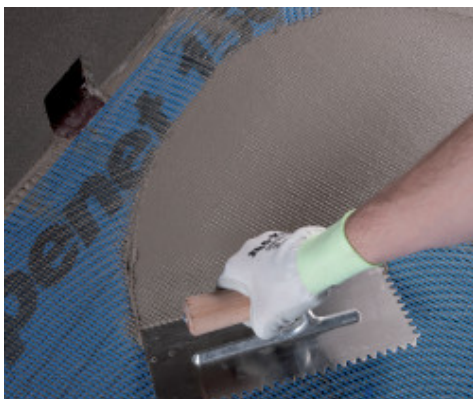
Aplikácia Mapelastic na výstužnú mriežku Mape-net 150
