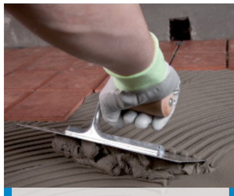
Aplikácia lepidla Granirapid na terasu zaizolovanú s použitím Mapelastic
