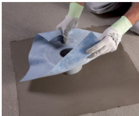
Aplikácia odtokovej vpuste Drain Vertical do hydroizolácie Mapelastic
