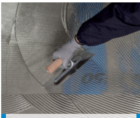
Zapracovanie Mapenet 150 do prvej vrstvy Mapelastic Turbo pokiaľ je ešte čerstvá
