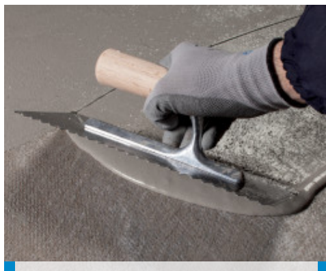
Aplikácia druhej vrstvy Mapelastic Turbo na prvú vrstvu vystuženiu s tkaninou Mapetex Sel N
