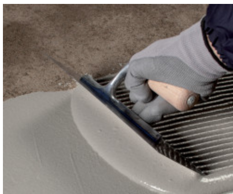
Aplikácia prvej vrstvy Mapelastic Turbo
