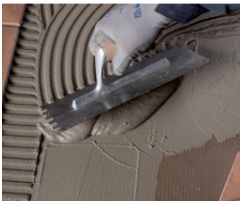
Inštalácia dlažby s použitím Elastorapid
