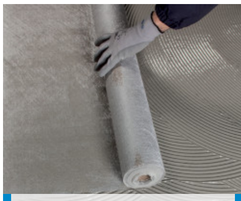
Zapracovanie Mapetex Sel N do prvej vrstvy Mapelastic Turbo pokiaľ je ešte čerstvá
