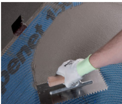
Aplikácia Mapelastich Zero na výstužnú mriežku Mapenet 150
