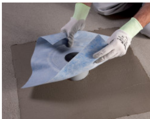
Aplikácia odtokovej vpuste Drain Vertical do hydroizolácie Mapelastich Zero
