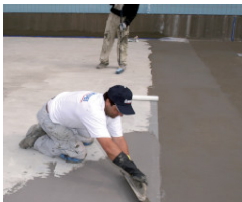
Mapelastich Zero použitý pri izolovaní plaveckého bazéna
