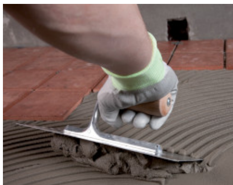
Aplikácia lepidla Granirapid na terasu zaizolovanú s použitím Mapelastich Zero
