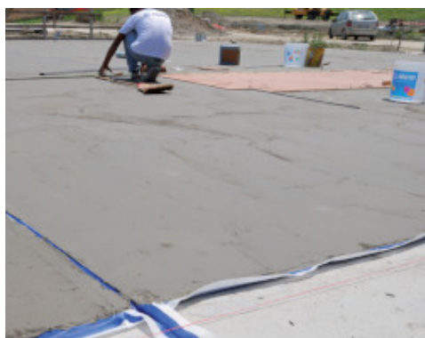
Izolovanie cementového poteru s použitím Mapelastick Zero a Mapeband
