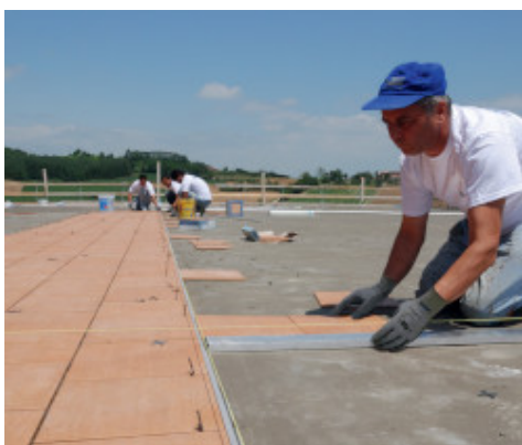
Inštalácia keramickej dlažby s lepidlom Kerabond + Isolastic
