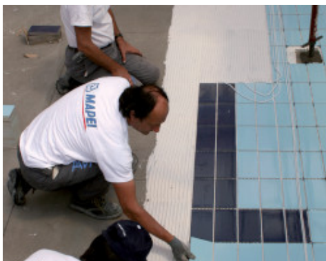
Lepenie keramickej dlažby v bazéne na zaizolovaný podklad s použitím Mapelastich Zero
