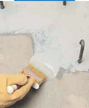
Aplikácia hmoty Eporip pomocou štetky v mieste pracovnej škáry.
