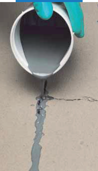
Eporip použitý pri oprave trhliny v cementovom poteri.
