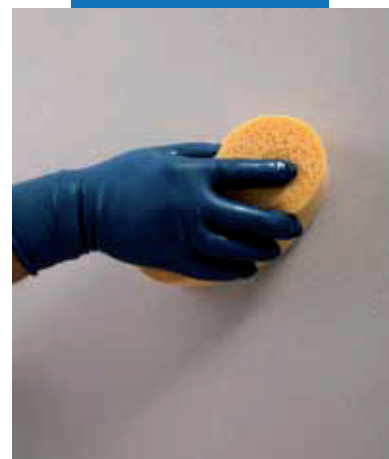
Dokončenie povrchu Mape-Antique FC Grosso navlhčenou hubkou
