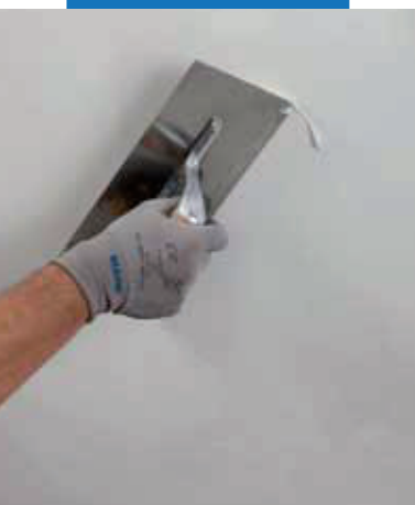
Spôsob nanosenia Mape-Antique FC Ultrafine
