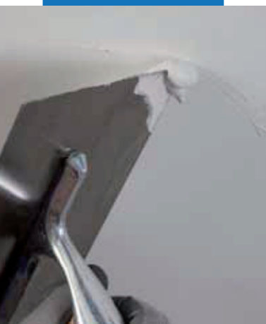
Vyhľadanie povrchu Mape-Antique FC Ultrafine
